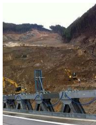
山崩れ復興工事中
